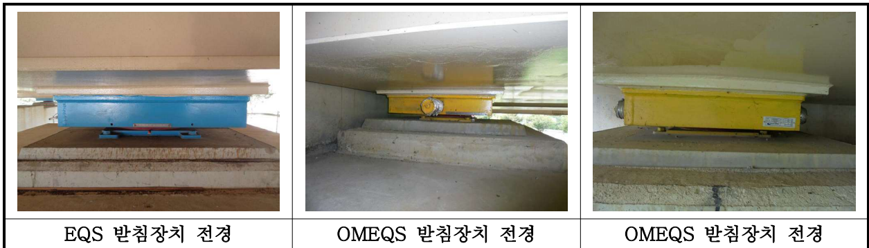
【사진 4.3.12】 교량받침 전경
