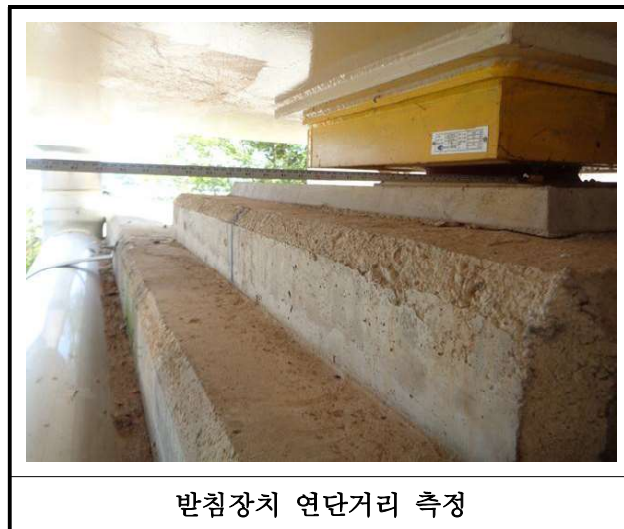
【사진 4.3.14】 교량받침장치 연단거리측정
