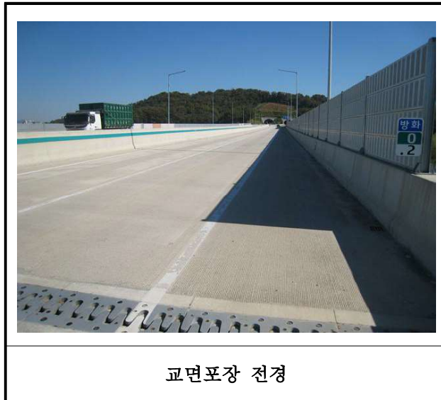
【사진 4.3.19】 교면포장 전경
