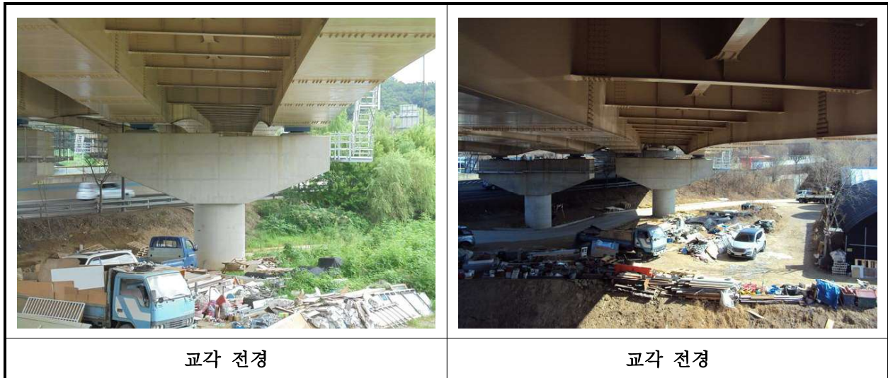
【사진 4.3.10】 교각 전경
