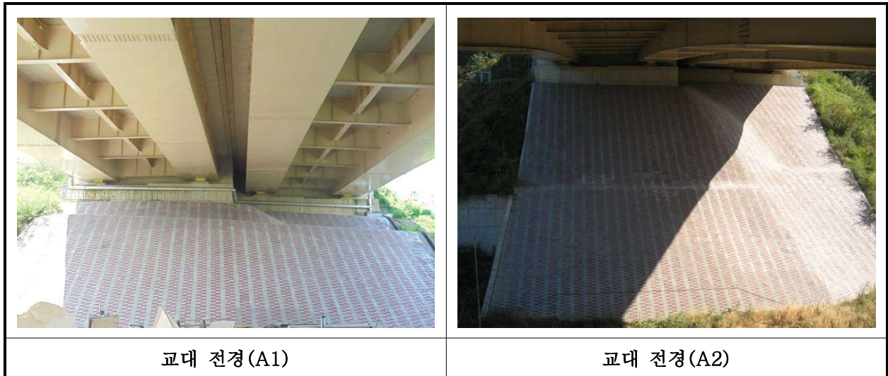
【사진 4.3.8】 교대 전경
