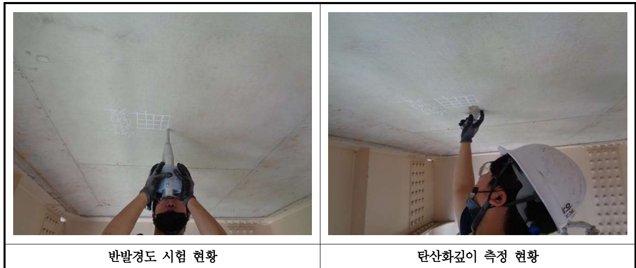
【사진 4.4.1】 콘크리트 내구성조사 현황
