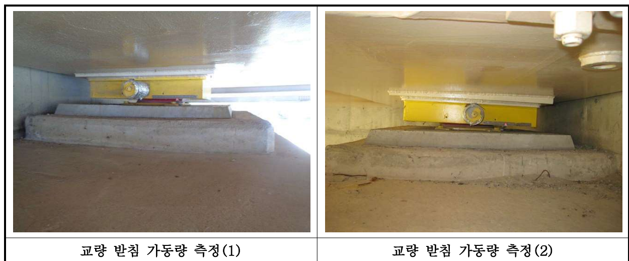
【사진 4.3.15】교량받침 이동량 측정
