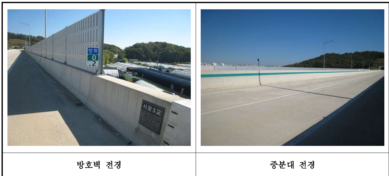
【사진 4.3.23】 방호벽 및 중앙분리대 전경
