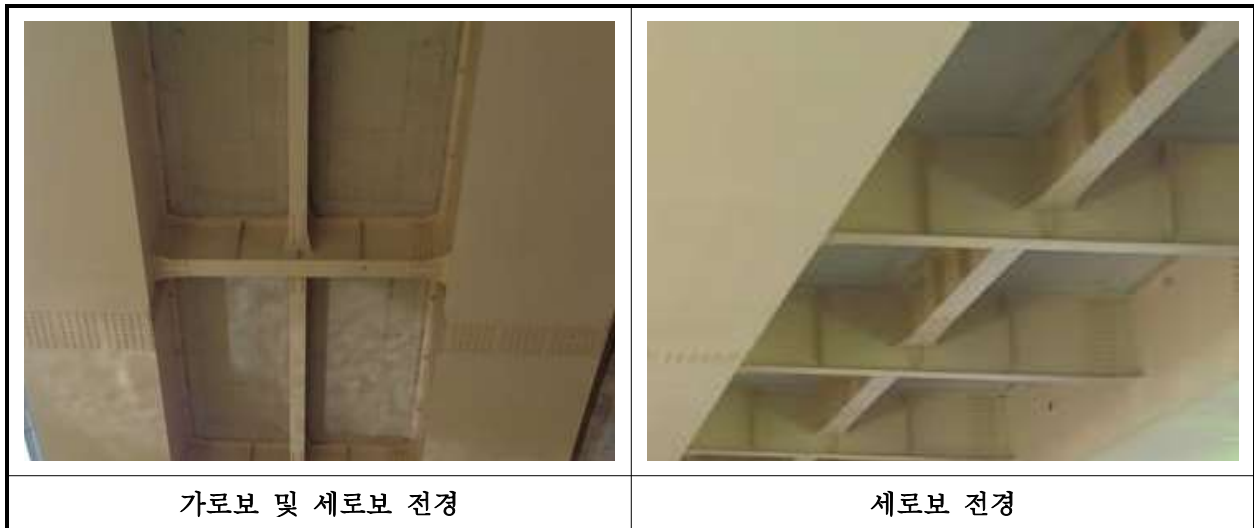
【사진 4.3.6】 가로보 및 세로보 전경
