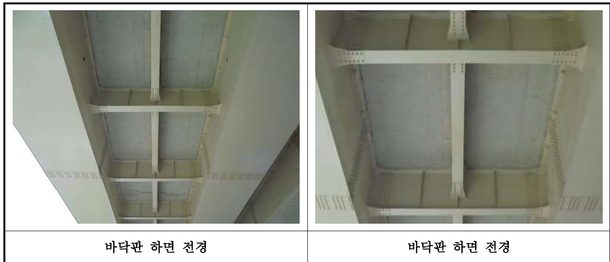
【사진 4.3.2】 바닥판하면 전경
