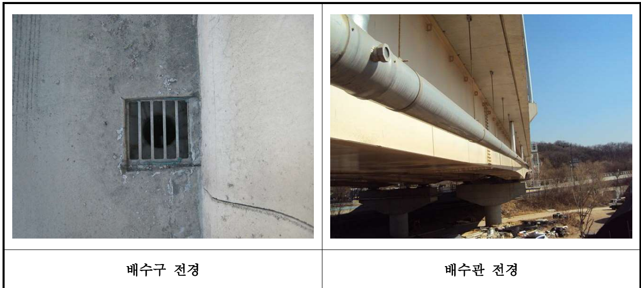
【사진 4.3.21】 배수시설 전경
